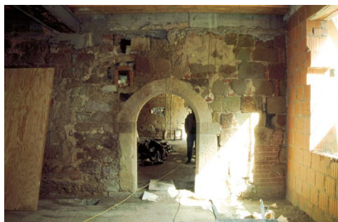
Kelleranlage vor der Restaurierung. Heute gehört er zu einem Restaurant. Rechteinhaber: TLDA Weimar
